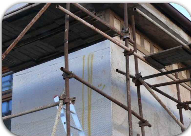
Obrázek 3 - Stěna vlevo izolována aerogelem s přikotveným pletivem (sprejem vyznačeny inženýrské sítě – nevrtat otvory pro kotvy), stěna vpravo vyrovnávána, natřena penetračním nátěrem a lepidlem, připravena pro přikotvení aerogelu.
