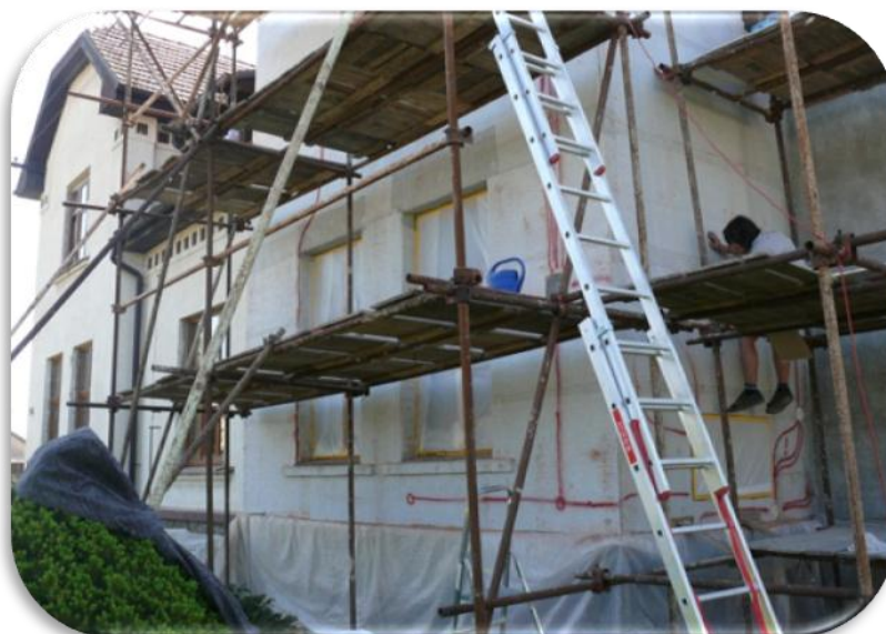
Obrázek 4 - Fasáda kompletně obalena aerogelem a pletivem včetně zděných konstrukcí parapetů s vyznačenými inženýrskými sítěmi je připravena pro maltový prostřík.
