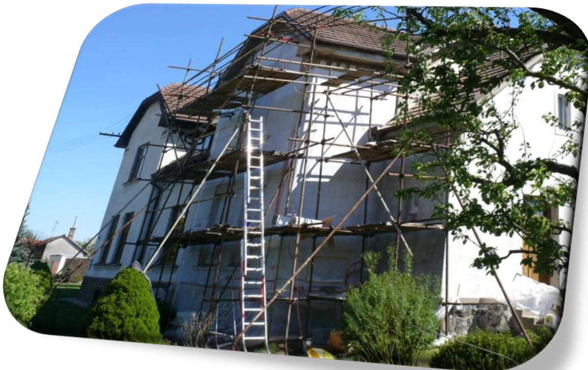
Obrázek 1 - Izolace aerogelem - část domu s lešením
