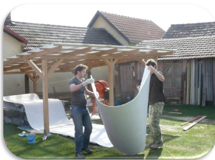
Obrázek 2 – Manipulace s aerogelovou izolací je velmi snadná. Je možné řezat pásy libovolné velikosti a tvaru.
